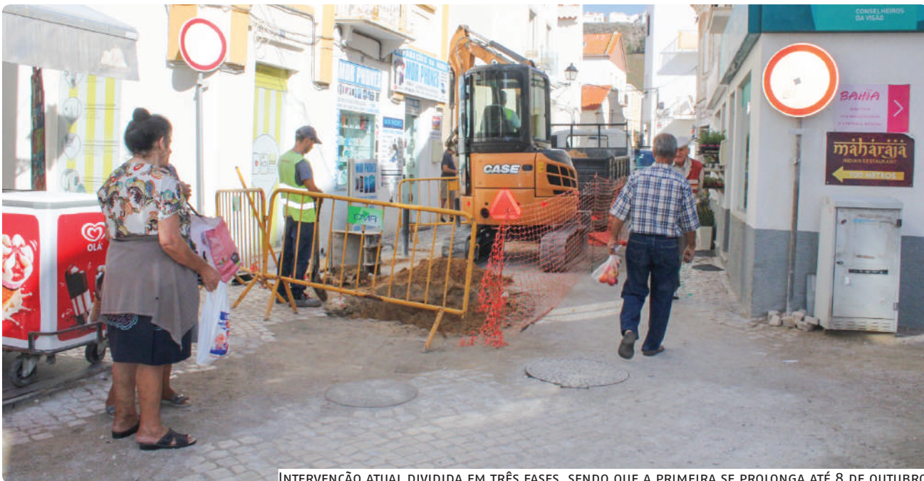
INTERVENÇÃO ATUAL DIVIDIDA EM TRÊS FASES, SENDO QUE A PRIMEIRA SE PROLONGA ATÉ 8 DE OUTUBRO
